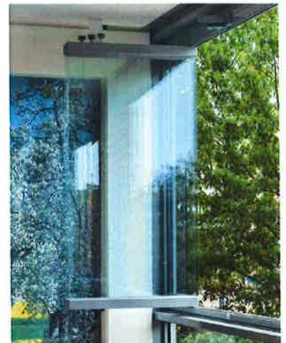
Abbildung 1: Beispiel Balkonfassade, verglaste Loggia, Innenansicht /21/
